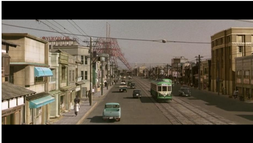
Gambar 16. Jalanan kota Tokyo dan proses pembangunan menara Tokyo
