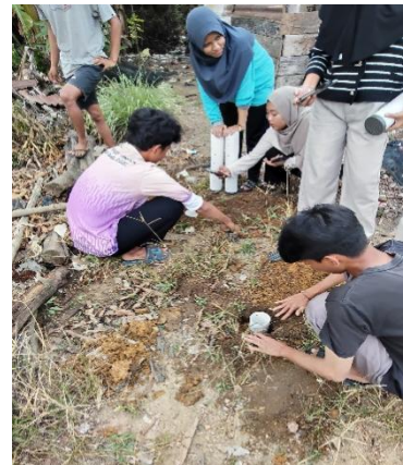
Gambar 3.4 Pemasangan Pipa Biopori
