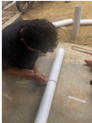
Gambar 3.1 Pengukuran Pipa Biopori
