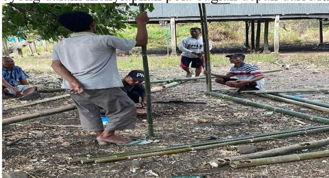
**Gambar 1. Pembuatan kerangka bagian *Marra'***
